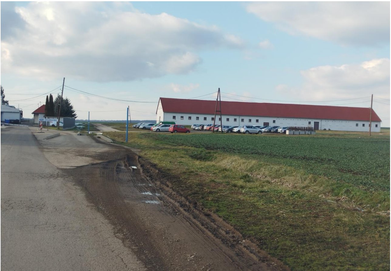
Egykori akol és parkoló a 054/4 hrsz. ingatlanon. Balra a hídmérleg és a tejüzem bejárata
